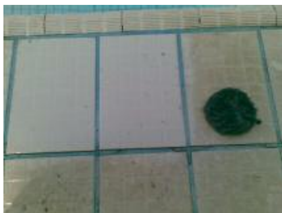
Esempio di ripristino pavimento bordo vasca
