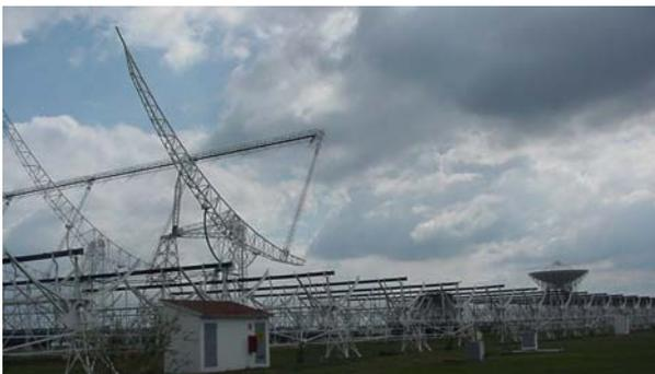
Il principio delle cosiddette croci di Mills, dal nome del loro progettista, è di unire due antenne allungate in direzioni perpendicolari e di connetterle ai ricevitori in modo che il loro fascio abbia la forma di un sottile pennello anziché, come quello di una sola delle
