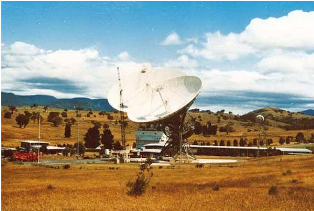
Uno dei maggiori vantaggi di questo tipo di radiotelescopi è rappresentato di contro dalla possibilità di abbracciare una larga banda di frequenze con il semplice cambiamento dell'antenna posta nel fuoco del paraboloide. I maggiori radiotelescopi a paraboloide mobile
