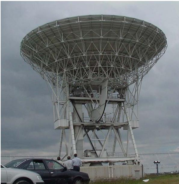
Il paraboloidale ha una superficie riflettente di 32 metri di diametro e, a differenza della Croce del Nord, può essere orientato in qualsiasi direzione grazie alla montatura altazimutale. Il moto di inseguimento avviene su due assi, verticale e orizzontale, ed è comandato da un calcolatore che effettua in tempo reale la conversione delle coordinate. I ricevitori dell'antenna sono posti al fuoco primario o al fuoco Cassegrain. Il
