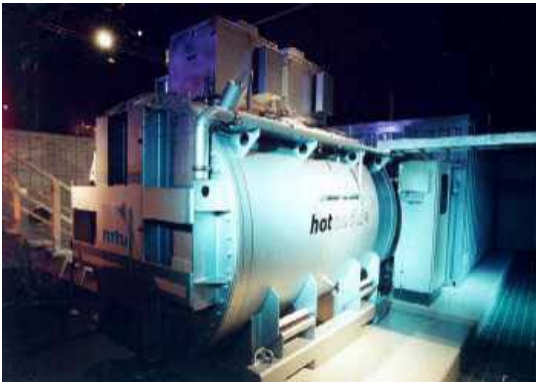
Unità da 250 kW in prova presso il Rhoen-Klinikum, Bad Neustadt/Saale (D)
