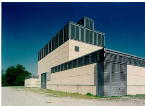
Impianto PAFC da 1,3 MW installato a Milano
