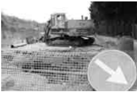
I lavori in via Scalazza realizzati l'anno scorso
