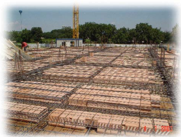
Figura 1.1: Esempio di solaio laterocementizio in fase di getto.
